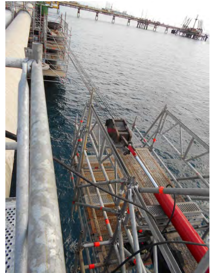
Sistema di tiro dei pali con il martinetto esteso e i cavi.
